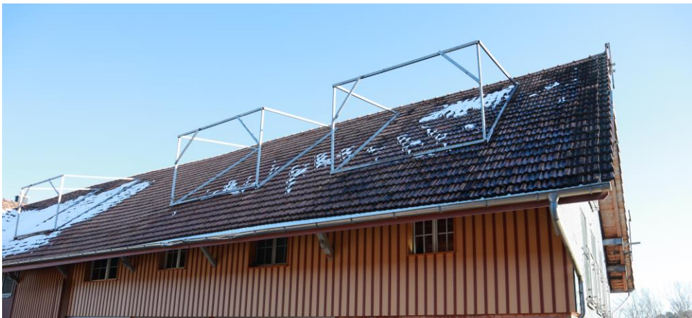
Abbildung 10: Aufnahme der Scheune mit geplanten Dachgauben
