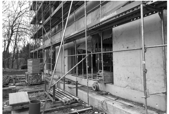
Rund 1'100 m 3 Beton und 145 Tonnen Bewehrungen wurden verbaut. Für die Elektroinstallation wurden rund 13'500 m Stark- und Schwachstromkabel verbaut.
