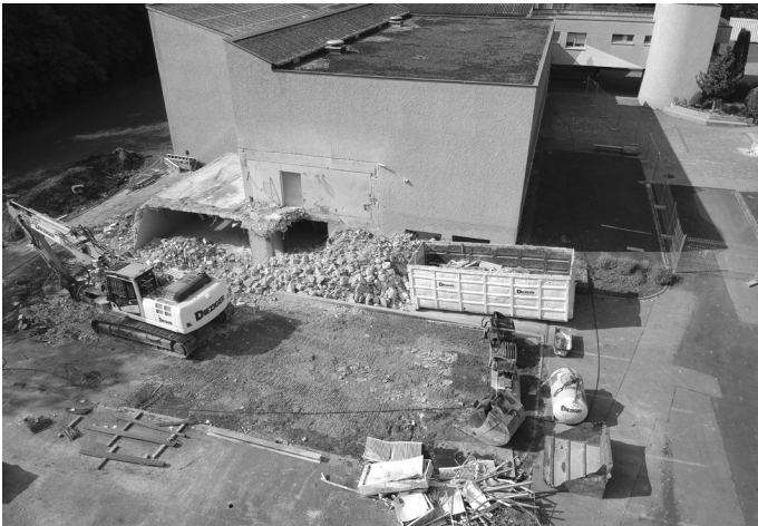
Die Arbeiten starteten mit dem Teilabbruch am nördlichen Teil des Gebäudes.
