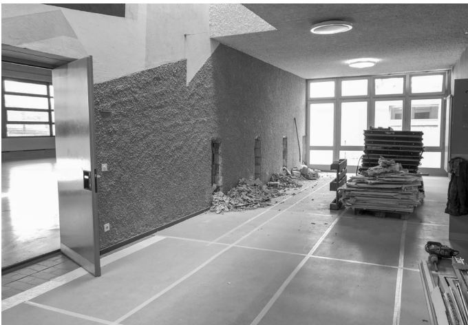
Es folgte die Erdbebenertüchtigung, welche für öffentliche Bauten vorgeschrieben ist.
