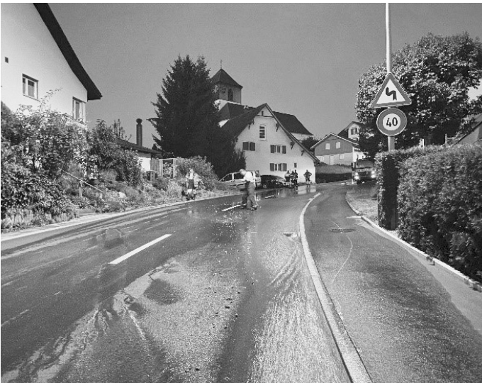
Einsatz Dorfstrasse, Wasserrohrbruch
